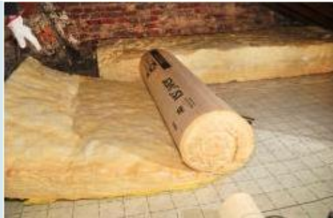
Isolation de comble perdu par rouleau
