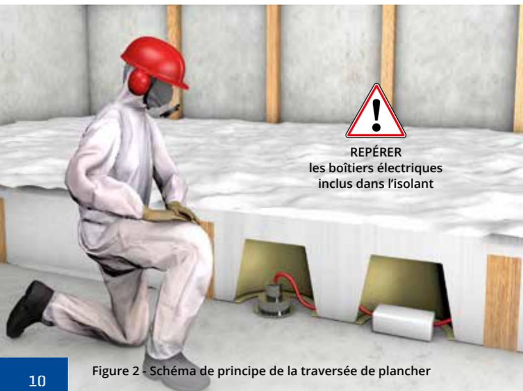
Figure 2 - Schéma de principe de la traversée de plancher
